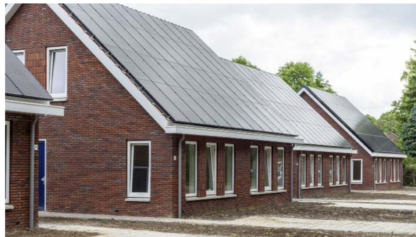
Woonborg heeft inmiddels 117 Nul-op-de-Meter (NOM)-woningen binnen de voorraad, die in een jaar gemiddeld even veel energie opwekken als verbruiken. Foto: Woonborg/Tieme Dekker
